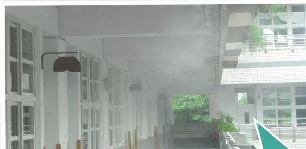
高樓層教室裝置噴霧降溫裝置，大幅降低教室溫度
